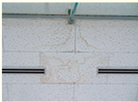
屋根部(雨漏り)
