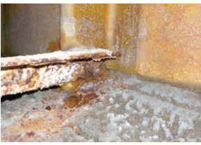
プール缶体の補強材(腐食)
